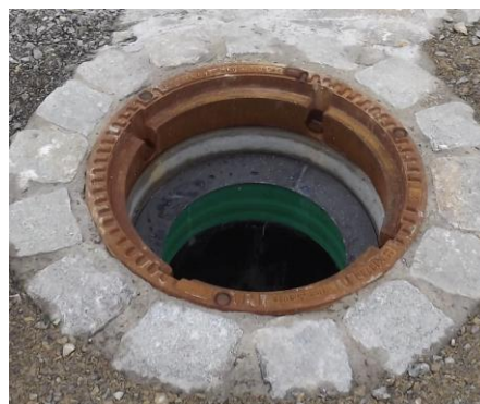
Beispiel: SR-Systemabschluss am Steigrohr DU 600 (DN 500) Betonring 625 mm
