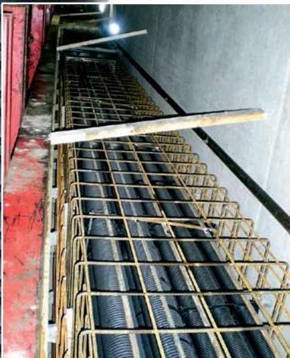
Kabelpaket in der Armierungslage zur Auftriebssicherung
