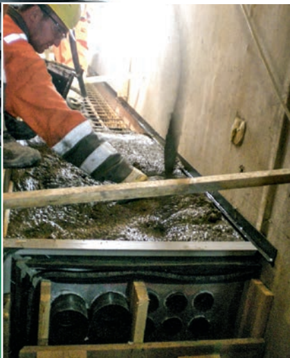
Einbringen des Betons und lückenlose Verfüllung der Rohrzwischenräume
