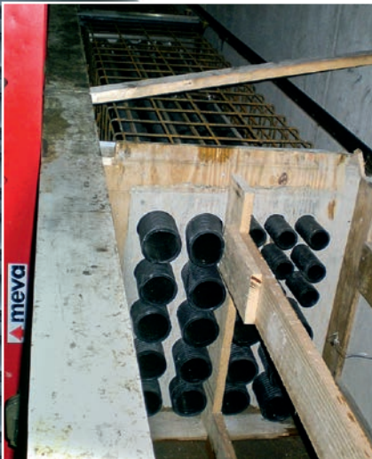
Trennschalung zum Kabelzugschacht
