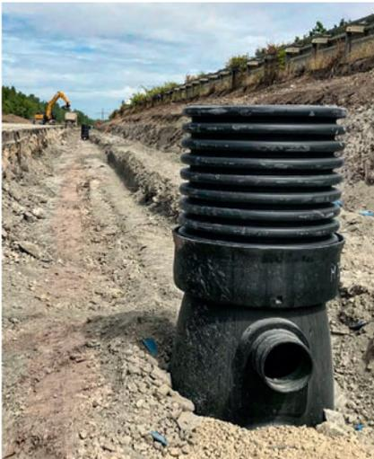
Vorgezogene Entwässerung mit dem stabilen Schachtsystem MULTI-inspect DUO vor dem Abbruch der Betondecke
