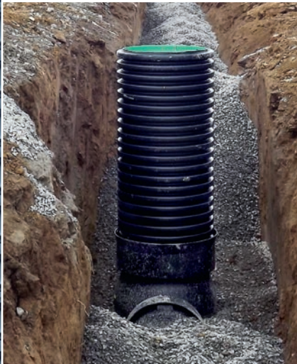
Streckenentwässerung mit dem Kontrollschachtsystem MULTI-inspect 600 und Sickerrohr SIROPLAST-K
