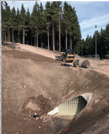
Trassenausbau der Schlüsselstelle „Birksteig“ mit neuer Streckenentwässerung und Besucherunterführung
