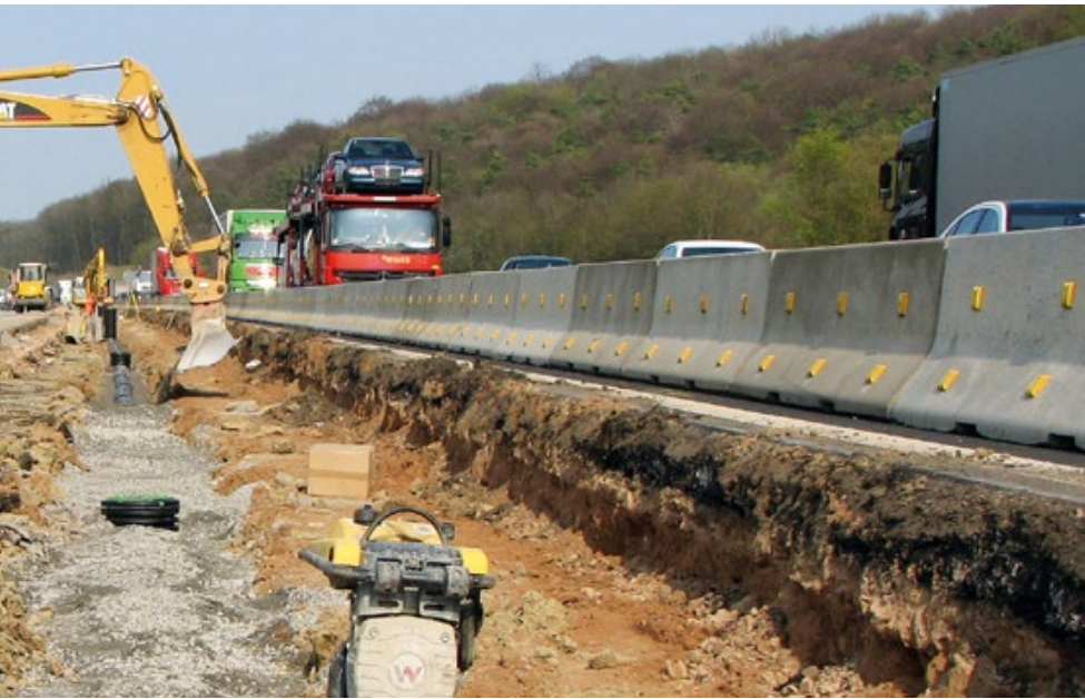
Einbau unter Verkehr bei beengten räumlichen Platzverhältnissen im Mittelstreifen
