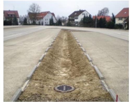
Parkplatz Muldenentwässerung mit beidseitiger offener Bordsteinfassung
