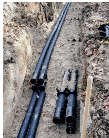
Erdverlegte HEKAPLUS-Schutzrohre für die großflächige Verbindung aller Solarmodule
