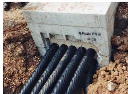
Die Verfüllung der Leitungszone (Rohrgrabensohle bis mindestens 20 cm über Rohrscheitel) hat fachgerecht lagenweise mit leichtem Verdichtungsgerät zu erfolgen. Die statischen Erfordernisse bezüglich des Verdichtungsgrades sind einzuhalten und bauseits zu prüfen.
