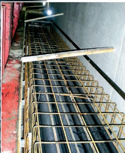
Kabelpaket in der Armierungslage zur Auftriebssicherung
