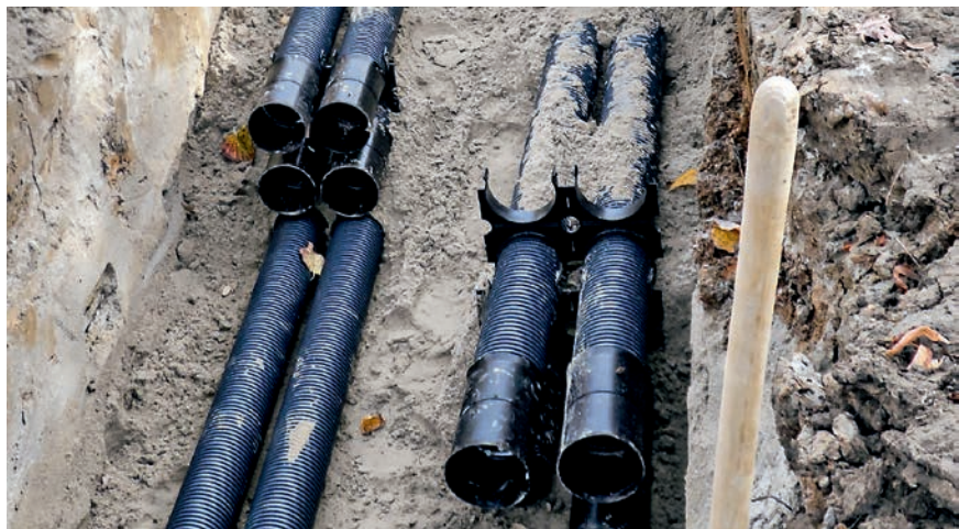
Mehrsträngige Verlegung von HEKAPLAST-S in Paketlage mit Abstandhaltern
