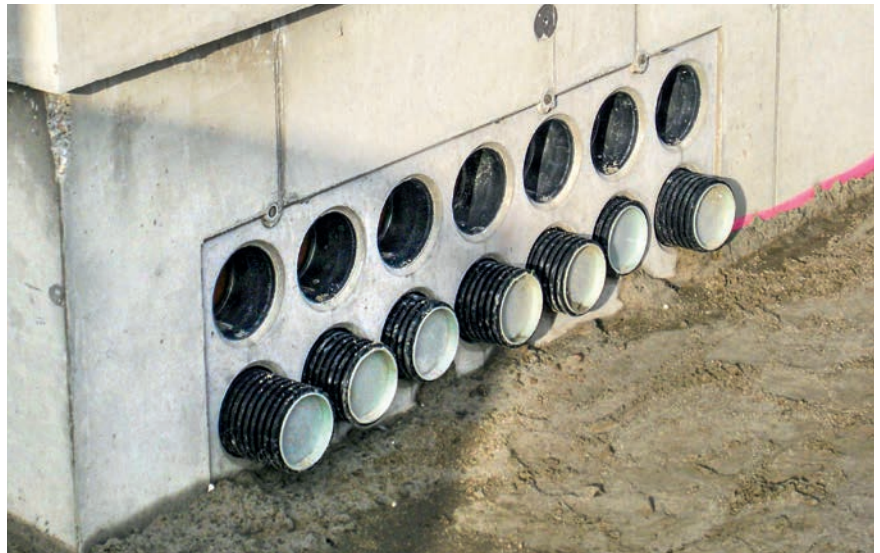
Fachgerechte Anbindung an einen Verteilerschacht aus Beton
