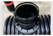
Das Oberteil in das Abdichtelement einschieben und so positionieren, dass die Befestigungspunkte für die Spannschrauben übereinanderliegen.
