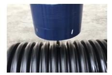
Mit der nennweitenspezifischen HEGLER-Bohrkrone (DN 150: Ø 176,0  $\pm$  1,0 mm, DN 200: Ø 217,0  $\pm$  1,0 mm) ist die Anschlussöffnung **senkrecht** zur Rohrachse herzustellen. Den Zentrierbohrer dabei im **Wellental** des Verbundrohres platzieren. Hierbei ist zu beachten, dass aussschließlich Originalteile aus dem HEGLER-Programm zum Einstatz kommen dürfen.
