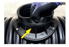
Das Abdichtelement bis zum Anschlag nach oben ziehen, bis seine untere Kante über den gesamten Umfang mit der Oberkante des Sattelstückes zusammenfällt.
