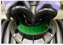
Das Abdichtelement einknicken und so weit in das Rohr einführen, dass sich die Dichtungslippe im Inneren des Rohres entfalten kann. Anschließend das Abdichtelement gegen die Rohrinnenwand nach außen ziehen.
