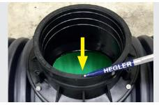
Ausrichtung des Abdichtelements überprüfen. Der Pfeil (\$\sqrt{\psi}\$) auf dem Rand des Abdichtelements muss über dem Steg des Sattelstückes und senkrecht zur Rohrachse positioniert sein.
