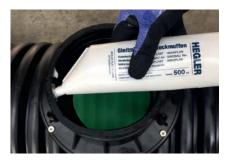
Die Innenfläche des Abdichtelements und die Außenfläche des Oberteils entlang dem Innenrohr mit HEGLER-Gleitmittel bestreichen.
