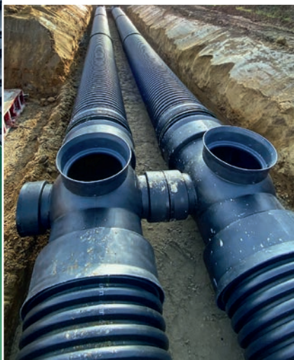
Querverbindung am MULTI-inspect für eine gleichmäßige Wasserverteilung
