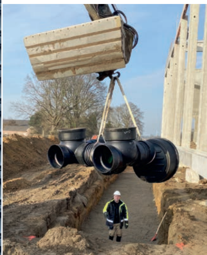
Einfache und zügige Verlegung der bauseitig vormontierten Schachtsysteme
