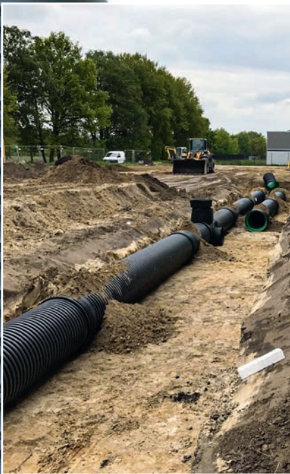
AQUATUB-Rw DN 600 in Kombination mit dem Schachtsystem MULTI-inspect MONO
