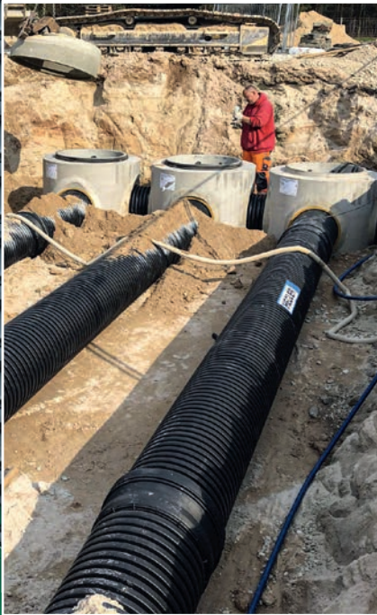
AQUATUB-Rw DN 500 mit Beton-Verteilerschächten
