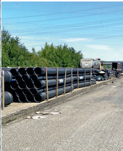
Problemlose Baustellenlagerung der Entwässerungskomponenten bei beengter Verkehrsführung 5 + 0
