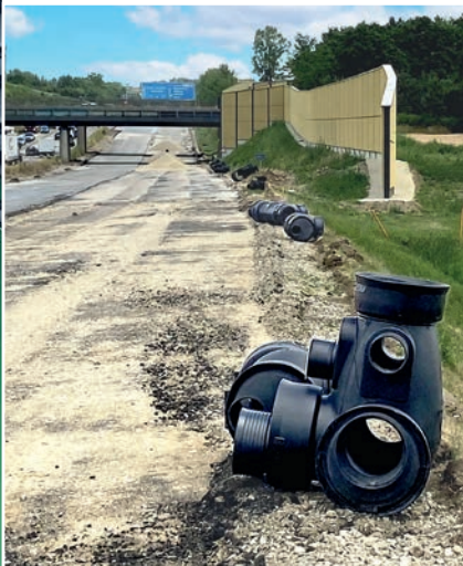
MULTI-inspect 400 DUO Einsatz im Trennstreifen vor der Lärmschutzwand bei beengten Platzverhältnissen
