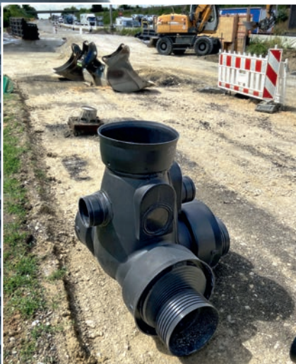
MULTI-inspect 400 DUO Schacht in Huckepackanordnung als Sonderbauteil Abzweigschacht 3 x 90°
