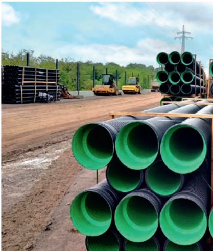
Lagerhaltung von Transport- und Sickerrohren
