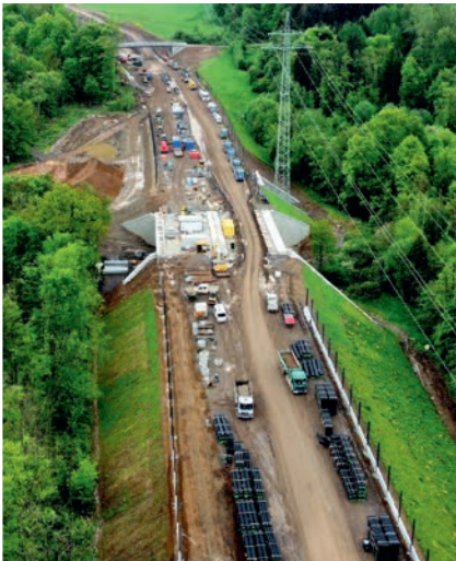
Vorbereitung der Entwässerungsbauweise AQUATUB-Rw und MULTI-inspect DUO für den Einbau in den Teilschnitten
