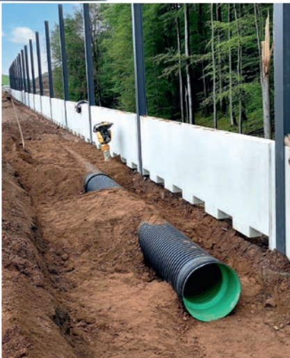
Verlegung von AQUATUB-Rw-Transport-Rohrsystem im Trennstreifen zwischen Fahrbahn und Lärmschutzwand
