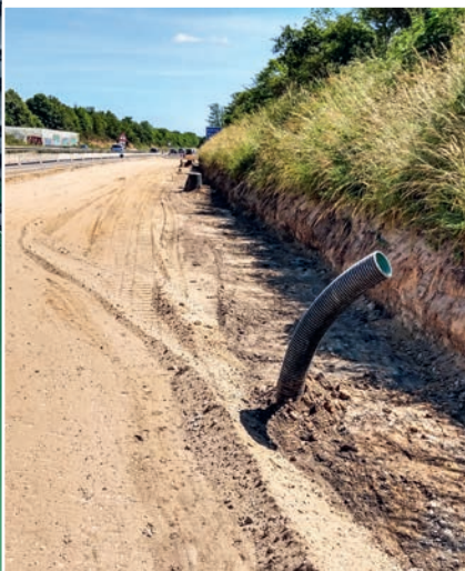
Anbindung der Muldenabläufe mit der flexiblen Rohrleitung AQUATUB-RwR DN 150
