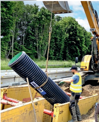
Einfaches Einführen der Transportrohre AQUATUB-Rw bei engem Rohrgraben mit Verbauplatten und Querstreben
