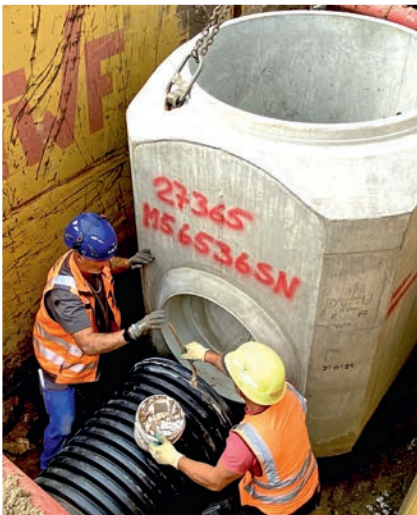
Zügige Verlegung der Rohrhaltung von AQUATUB-Rw mit Anschluss an einen Betonschacht
