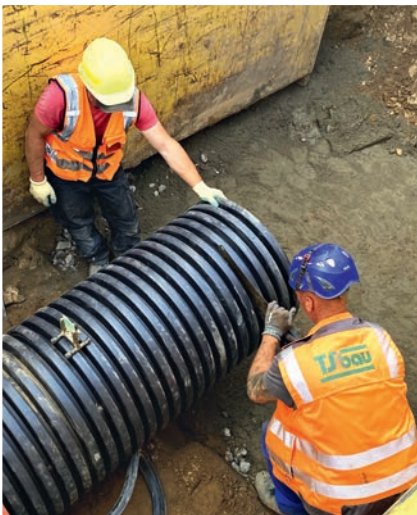
Vorteil von AQUATUB-Rw aus PE-HD: schnelles Kürzen auf die gewünschte Passlänge
